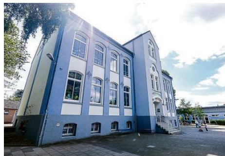
Die Gudrun-Pausewang-Grundschule an der Heinrichstraße erhält ab Mai einen Erweiterungsbau in Modulbauweise. Fertigstellung soll auch Ende September sein.
