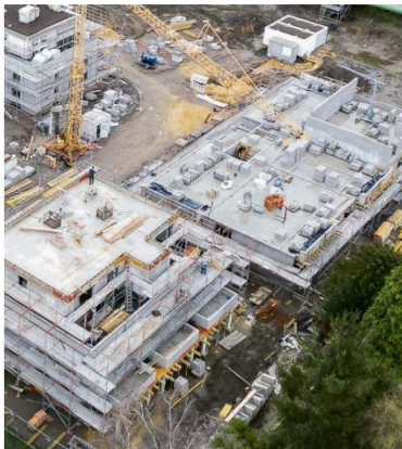
Auch an der Heinrich-Pardon-Straße wachsen zwei WG-Gebäude in die Höhe.
