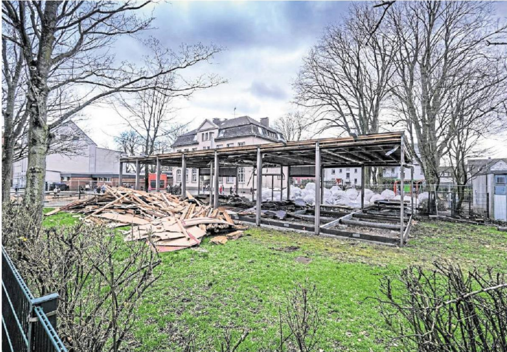
Bevor Neues entstehen kann, muss auf dem Gelände der Marienschule Altes weichen. Vom maroden Pavillon ist nur noch das Gerippe übrig. Bis September soll hier ein zweigeschossiger Neubau entstehen. —FOTO: JÖRG GUTZEIT
